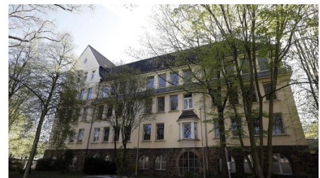
Die ehemalige Gemeinschaftshauptschule an der Gneisenaustraße in Duisburg sieht von außen noch so aus wie immer. Innen ist sie aber „nackig“. In vier Monaten startet hier die neue Gesamtschule Mitte/Süd. Fotograf/-in: FUNKE Foto Services
