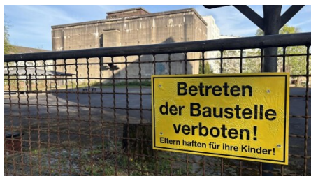
Hier ist noch viel zu tun: Das Gelände der alten Hauptschule Gneisenaustraße grenzt mit seinem Schulhof an einen alten Bunker. In vier Monaten wird die neue Gesamtschule Mitte/Süd eröffnet. Fotograf/-in: WAZ
